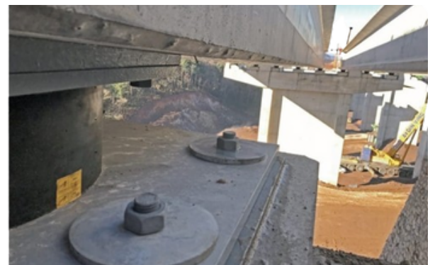
AISLADORES SÍSMICOS ELASTOMÉRICOS PARA PUENTES
