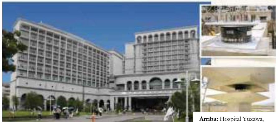
Arriba: Hospital Yuzawa, Japón. Debajo: Un deslizador instalado en el Hospital Takasu, Japón.
