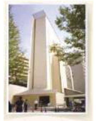
F-Museum Diez aisladores de caucho protegen estos 7 pisos y 40,000 pies cuadrados de construcción en Tokyo, Japón.
