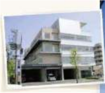
La Estación de Bomberos de Funabashi es una de muchas estaciones en Japón que has sido aisladas.
