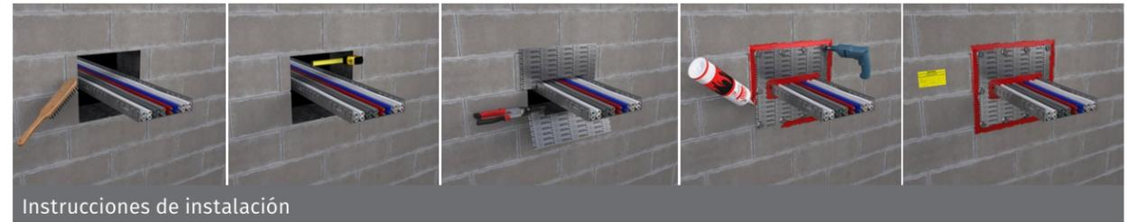
Nota: El material cortafuego debe instalarse de acuerdo con las instrucciones detalladas o el sistema aprobado.
