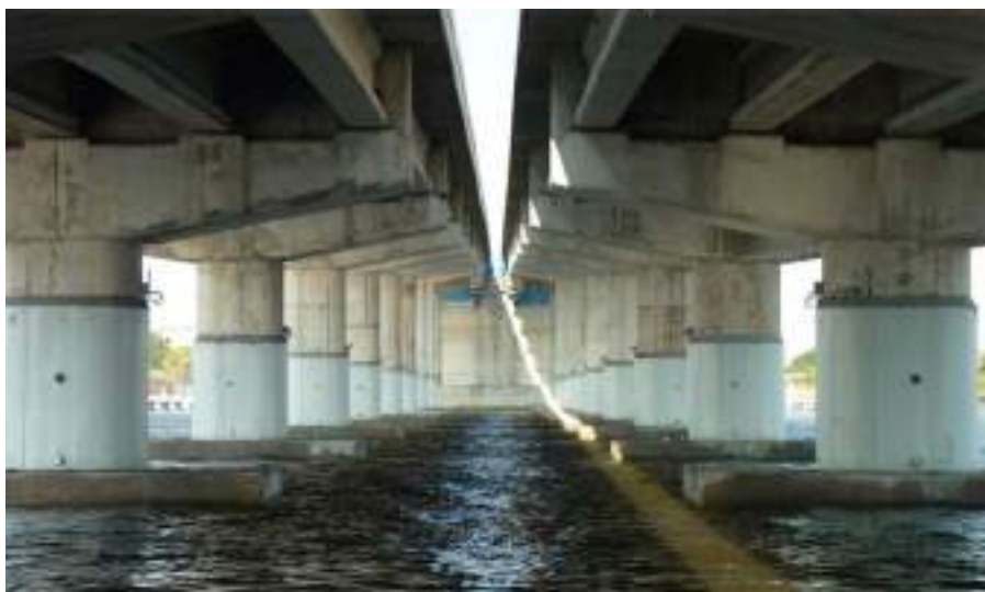
Enchaquetado con ánodos álcali activados SR802 OVER INTERCOASTAL WATERWAY
