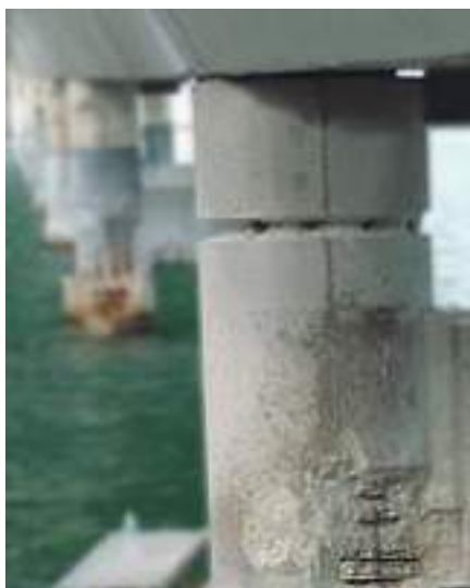
Remoción del concreto Zona Mareas / Salpicadura ASZ CAYOS FLORIDA
