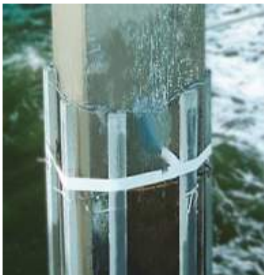
Ánodos álcali activados Zona Marea / Salpicadura ROBERT MOSES CAUSEWAY N.Y. 2006
